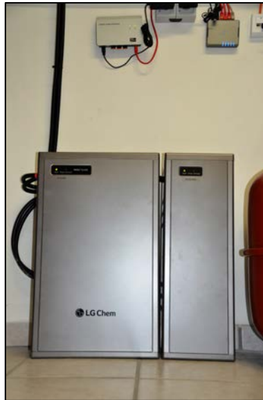
Batterieeinheiten (6,4 + 3,2 kWh)
