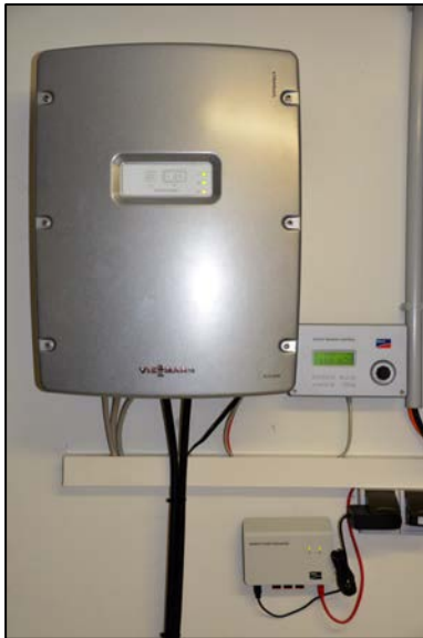
Batteriewechselrichter
